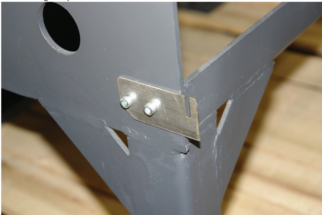
Fäste att hänga sidoplåt i underkant.
