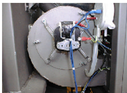
Bild 10 Rökgasfläkt
