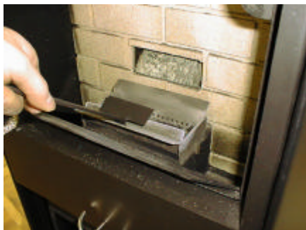
Bild 1 Urtagning av brännkoppen
