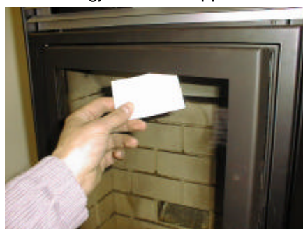
Bild 5 Rengöring av luftspalt
